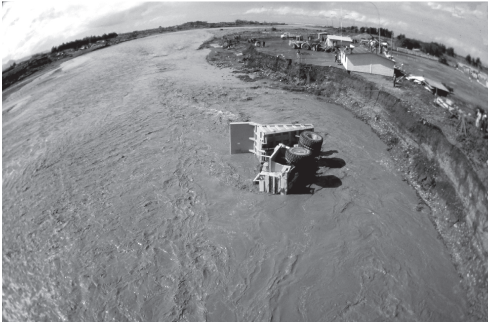
Anexo Fig. 8.12. La fuerza que lograron las aguas del Río Elqui cerca de la ciudad de La Serena amenazó con desmoronar las paredes más altas de su borde y arrastró maquinaria pesada que se encontraba en el lugar.
