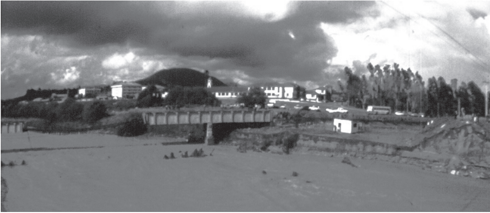
Anexo Fig. 8.11. La violencia del río afectó la ciudad de La Serena, anegando casas emplazadas en el borde del río, amenazando puentes y cortando vías de comunicación. En la foto se muestra cortado el puente ferroviario que une el mineral El Romeral con la bahía de Guayacán (zona de embarque de mineral).
